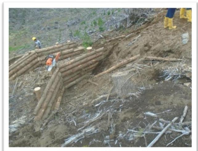
*Figura 14. Erosión hídrica y creación de estructuras para contener el suelo.*
